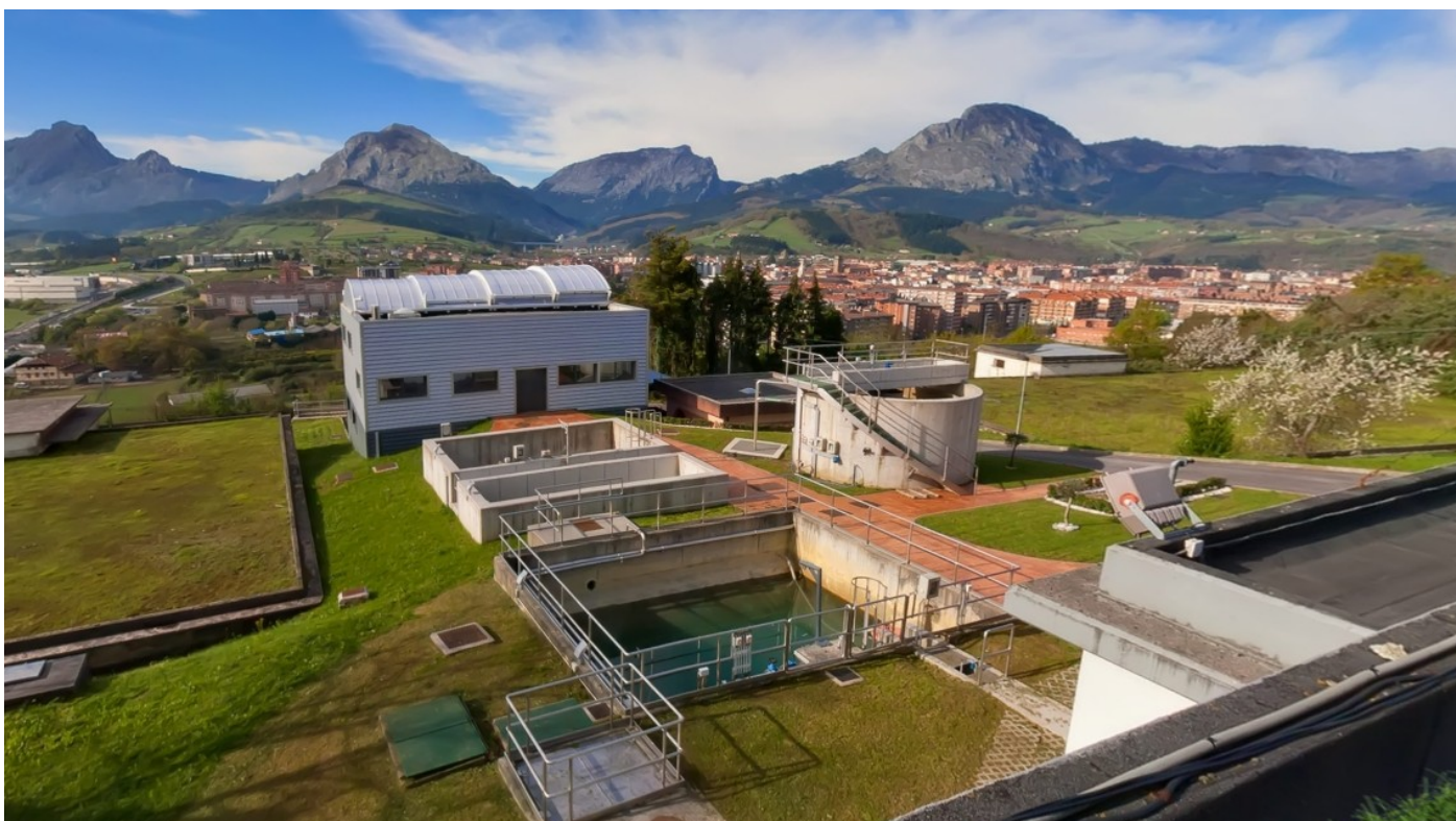
Imagen 7: ETAP de Gaizar. Fuente: https://visitas.consorciod eaguas.eus/eu/instalaciones
